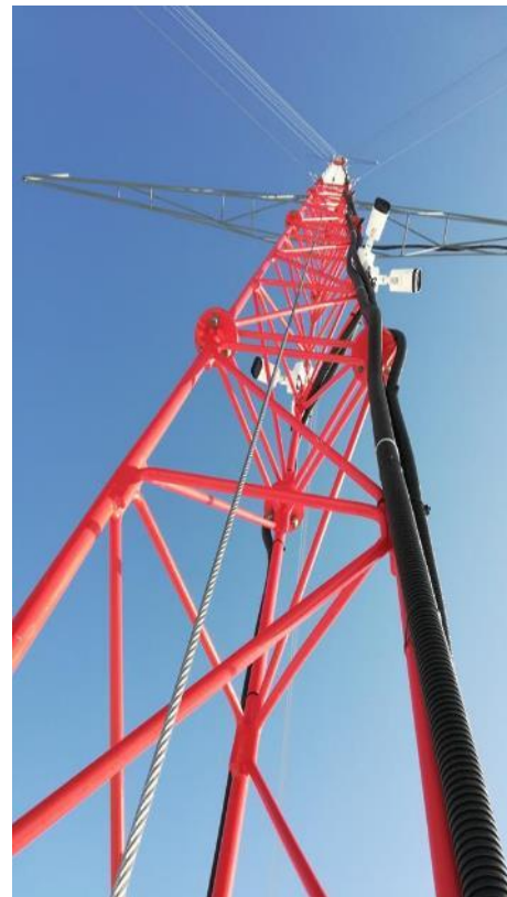
Maszt pomiarowy w Lubiatowie
